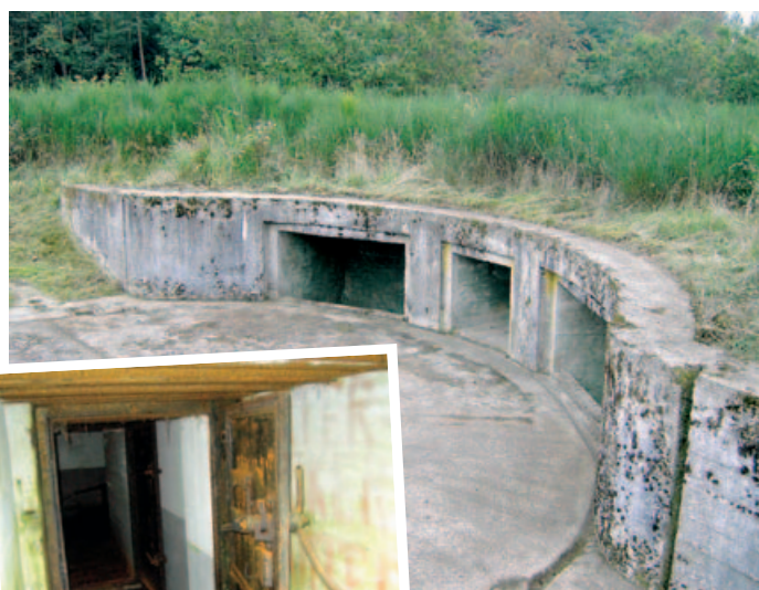
Oben: Stück einer 8,8 Flakstellung Links: Ein vor der Intervention des WZE seit 60 Jahren verschlossener Bunker, ebenfalls Teil der Tour
