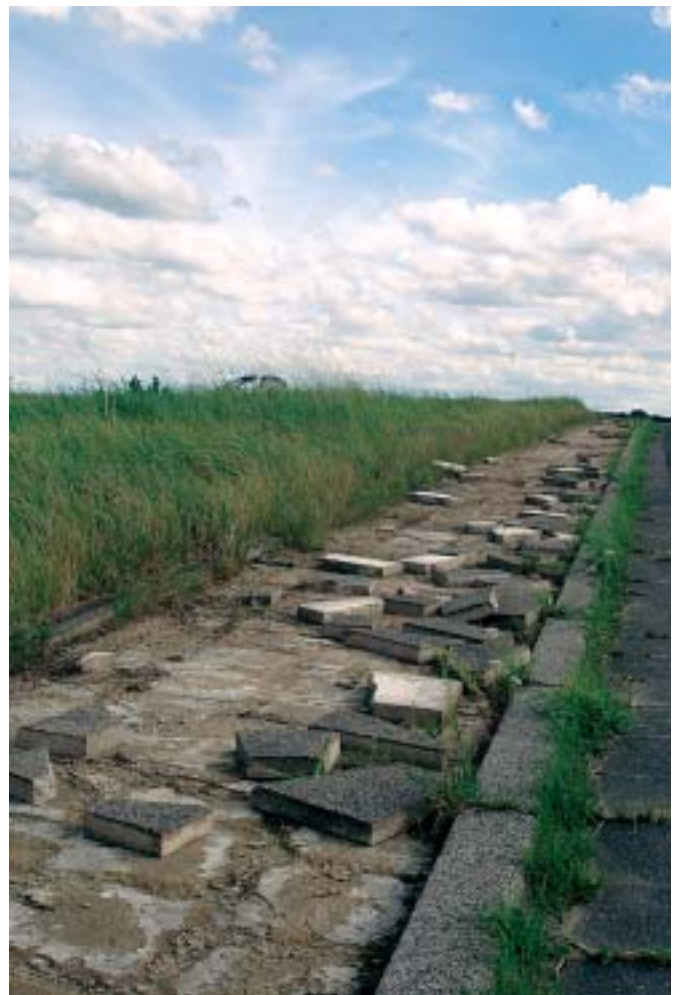
Hier wird alles ausgeschachtet (r.)
